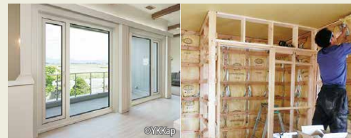
写真左：半日で断熱窓にリフォームできる「YKKap かんたんマドリモ」 写真右：壁の断熱リフォームの様子
