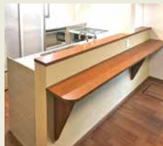
手元を隠せる腰壁にカウンターを造作
