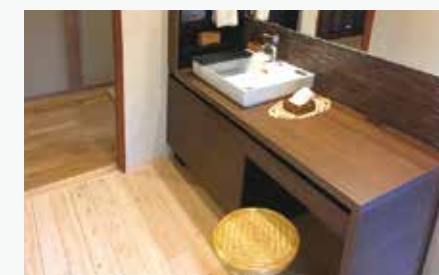
自然素材を取り入れてリフォームした洗面室。壁に珪藻土、 床には檜を使っています
