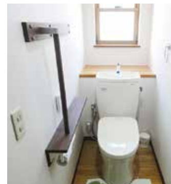
下地とカウンターが一体型の手すり
