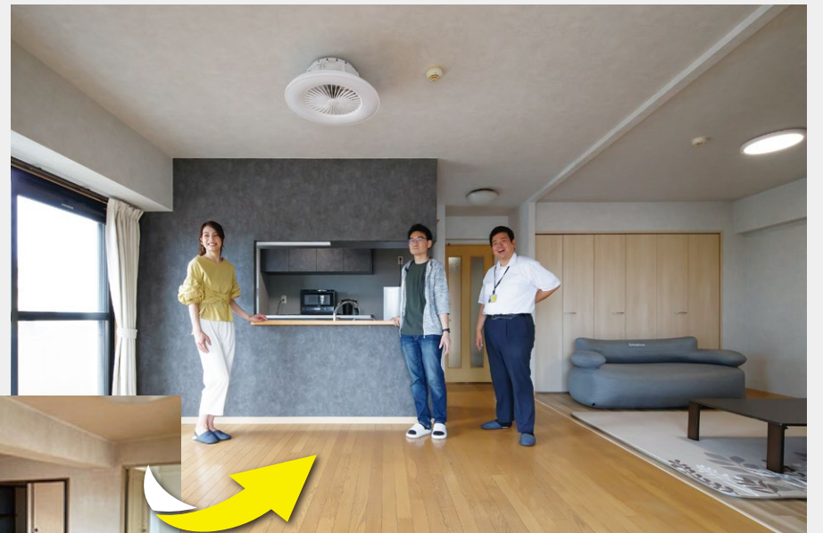
もともと和室だった部屋の仕切りにあった下がり壁を天井ギリギリまで撤去したため、空間に広がりを感じられます
